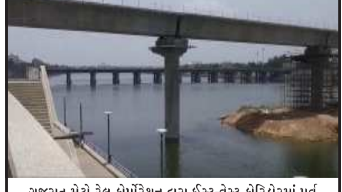
ગુજરાત મેટ્રો રેલ કોર્પોરેશન દ્વારા ઈસ્ટ-વેસ્ટ કોરિડોરમાં પૂર્વ અમદાવાદને પશ્ચિમ અમદાવાદ સાથે જોડતા સાબરમતી નદી પર મેટ્રો માટે ૩૦૦ મીટર લાંબો બ્રિજ તૈયાર કરાઈ રહ્યો છે જે કુલ ૮ પિલર પર છે જે શાહપુર પાસે ટનલમાંથી મેટ્રો બહાર નિકળી એલિવેટેડ કોરિડોર પર થઈ નદી પર તૈયાર થઈ રહેલા બ્રિજ પર થી થલતેજ સુધી જશે.
