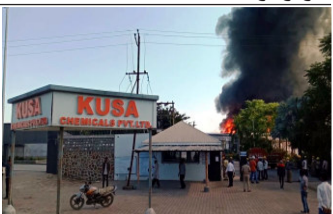
ગોધરા-વડોદરા હાઇવે પર આવેલ કુશા કેમિકલ કંપનીમાં ઘડાકા સાથે આગની ઘટના
